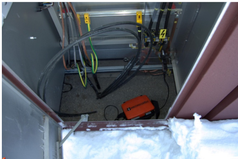
Figur 6. Metrotech kabelanvisningsutrustning.
