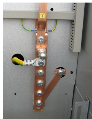
Figur 3. Stationsjordningsplint.
