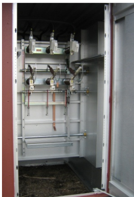
Figur 6. Infallsskydd demonterat ZT19/ZF19.
