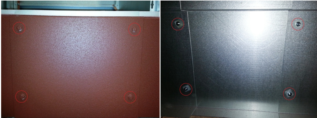
Figur 8. Demontering fundament ZT19/ZF19 (utsida resp. insida).
