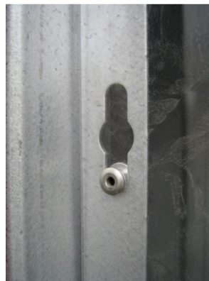
Figur 7. Fästpunkt i nyckelhåsurtag, infallsskydd ZT19/ZF19.
