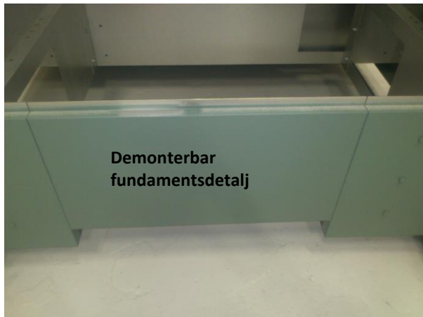
Figur 7 Demonterbar fundamentsdetalj.
