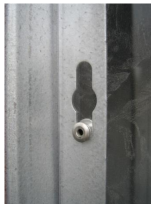
Figur 7. Fästpunkt i nyckelhålsurtag, infallsskydd ZT19/ZF19.
